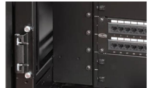
在使用传统方法难以密封的区域，垂直挡板可封住开放空间，防止气流分流。挡板改装后还可支持线缆管理。
