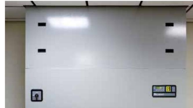
钢板支持免工具安装，可快速安装在现有CRAC单元上。
