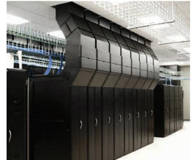
利用HCS，您在进行线缆管理时不需要中断路由或断开线缆和电源。图中显示的是伊顿的Paramount机柜系统。
